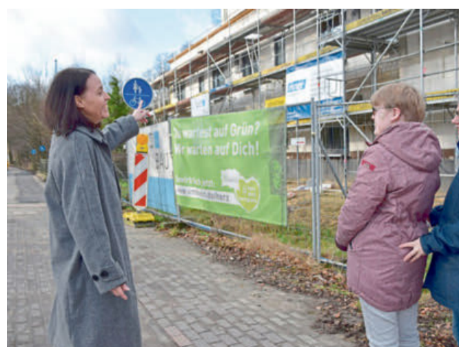
Vorfreude: (von links) Teamleitung Nicole Nüsken berichtet Federica und Stephanie Haus, wie es auf der Baustelle vorangeht.
